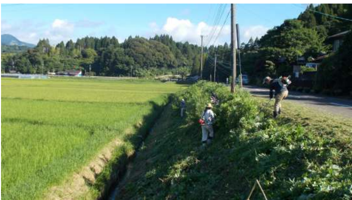
作業中（NO.51=萩之嶺下塚田線）
