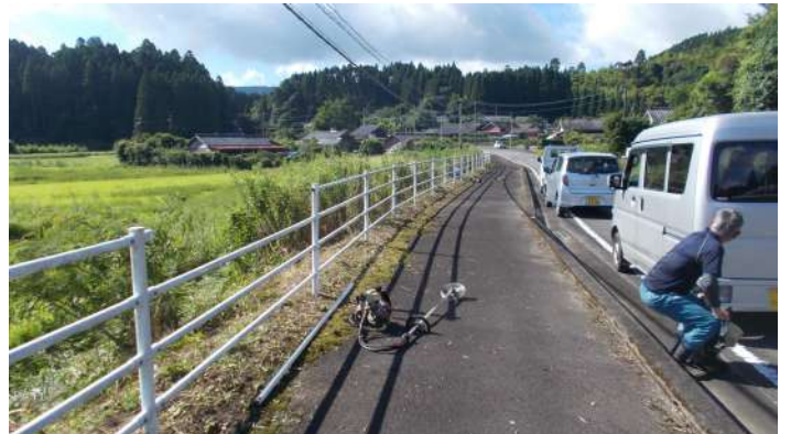
作業中 (NO.58=下塚田東下中線)
