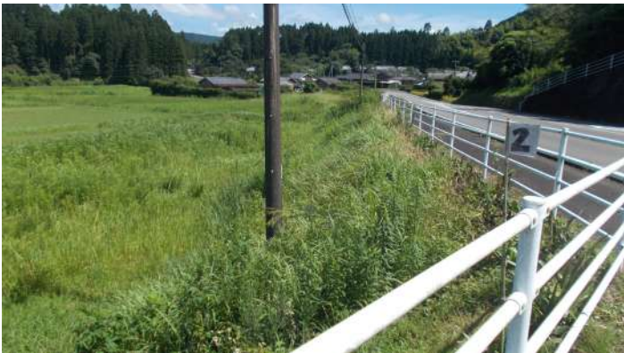
作業中 (NO.58=下塚田東下中線)
