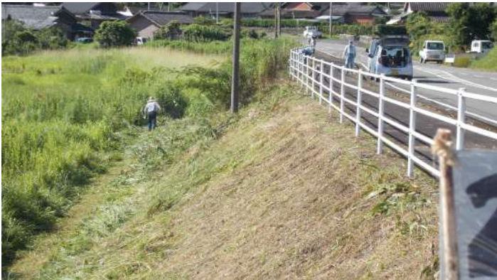
作業中 (NO.58=下塚田東下中線)
