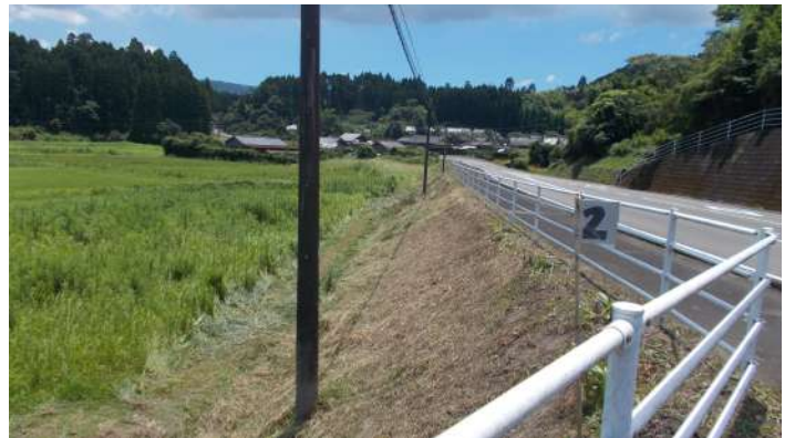
作業中 (NO.58=下塚田東下中線)
