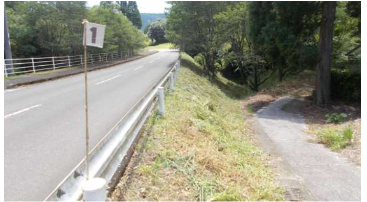
作業終了後 (NO.58=下塚田東下中線)
